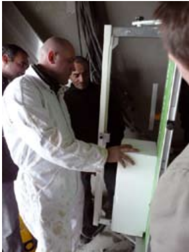
Mise en œuvre de l'isolation extérieure
