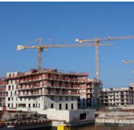
Le chantier de la ZAC de Bonne
