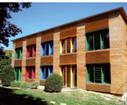
Un bâtiment rénové du groupe scolaire du Grégoire : les bardages bois et les fenêtres équipées de protections solaires
