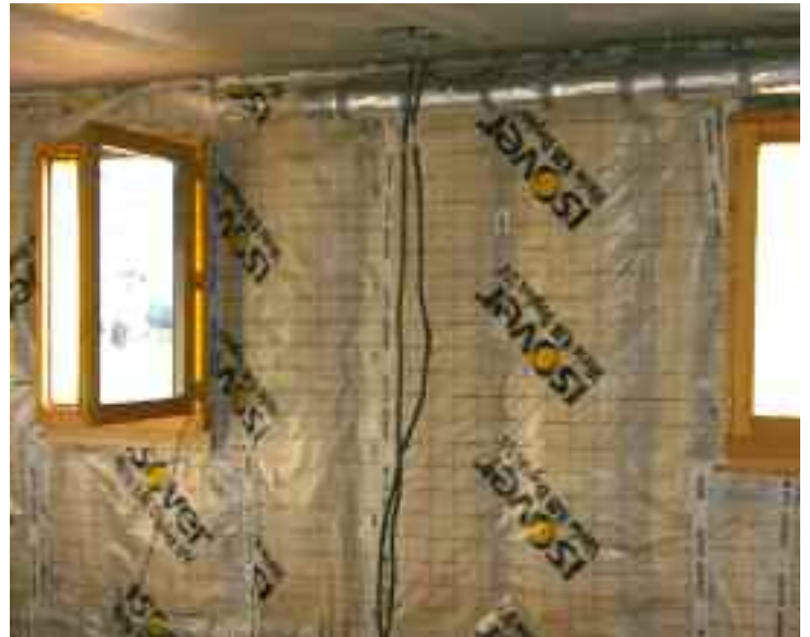
Isolation entre montants derrière le freine-vapeur, avant la pose du doublage intérieur sur rail métallique
