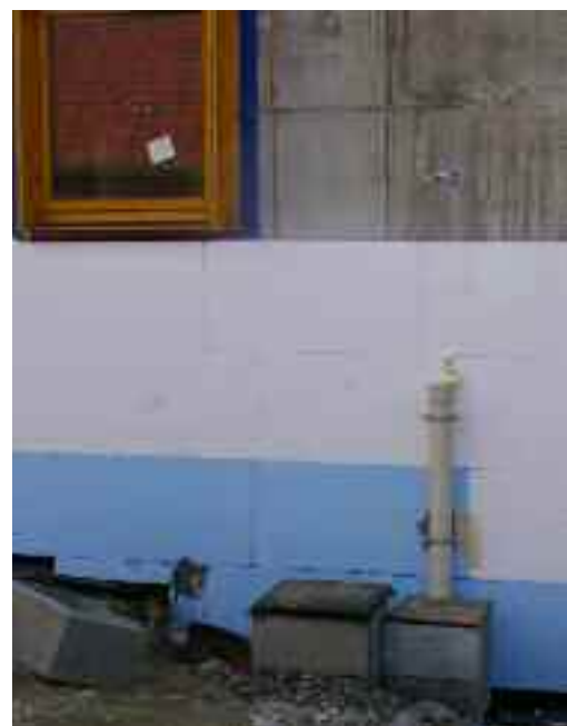
Le polystyrène expansé (blanc) est remplacé par du polystyrène extrudé (bleu) 20 cm avant le niveau du sol pour éviter les remontées capillaires d'eau.
