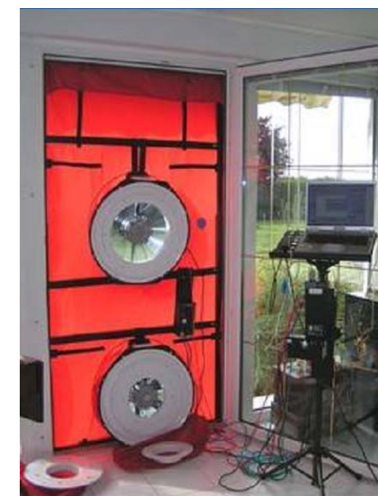
Photo 2 : porte soufflante ou blower door (Source : Alsatech)
