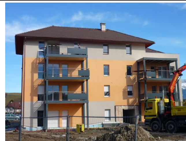
Photo 1 : Exemple de balcon autoporté (projet Jardin République à Epagny)
