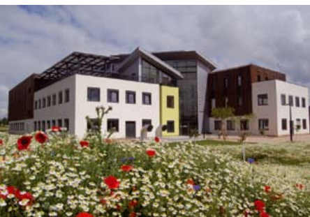
La Cité de l'Environnement à Saint-Priest
